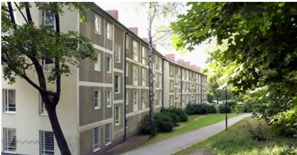
Hökarängen, flerfamiljshus byggt 1950.
